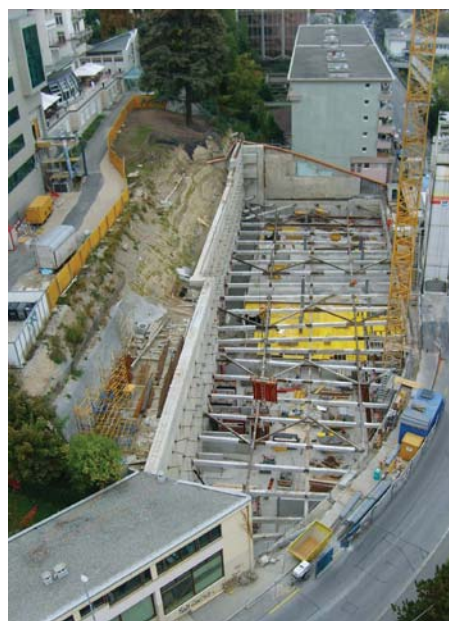
Paroi moulée après terrassement, étayage, ancrage
