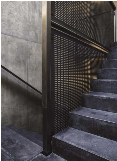
Escaliers de secours
